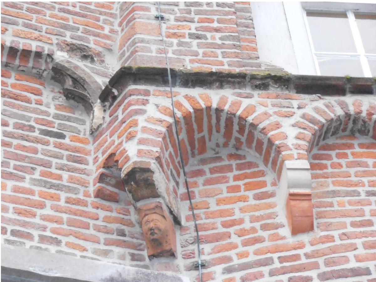
Identieke regenlijsten aan het kasteel van Croy te Laarbeek
